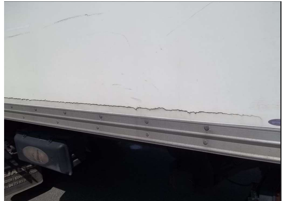
Panneau enfoncé, à réparer
