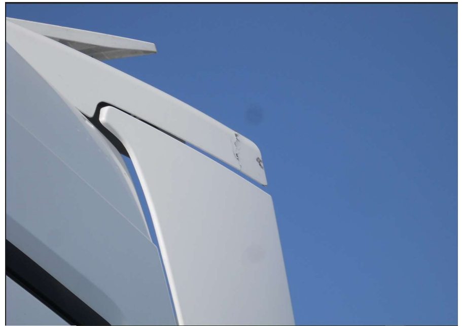
Déflexeur fissuré, à réparer
